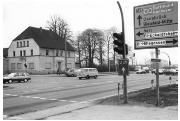
Die nicht mehr genutzte Gaststätte Eickelmann und die Eickelmannkreuzung einige Jahre vor dem Abbruch – um 1986.
