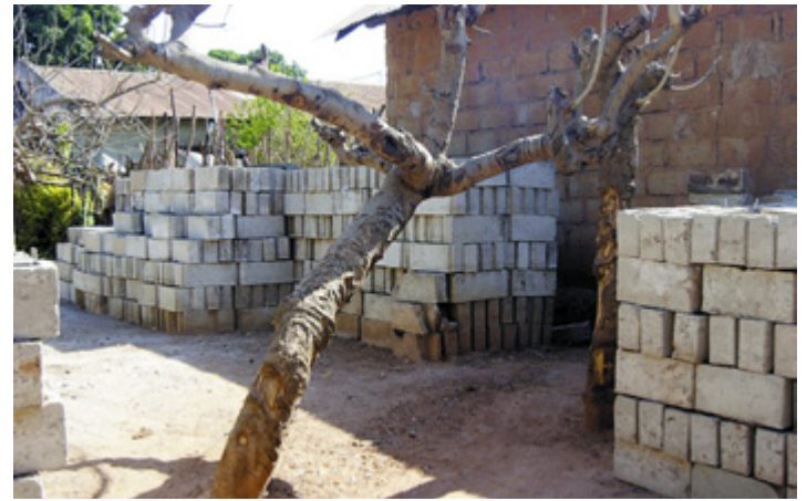
Handgefertigt und gestapelt liegen die Steine für die Reparatur bereit. Foto: Uwe Baicar
